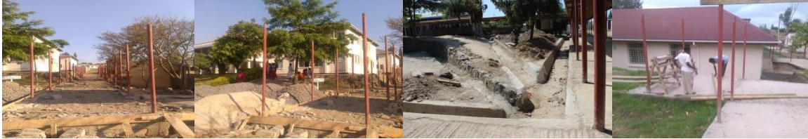
Ujenzi wa Njia Ukiendelea
