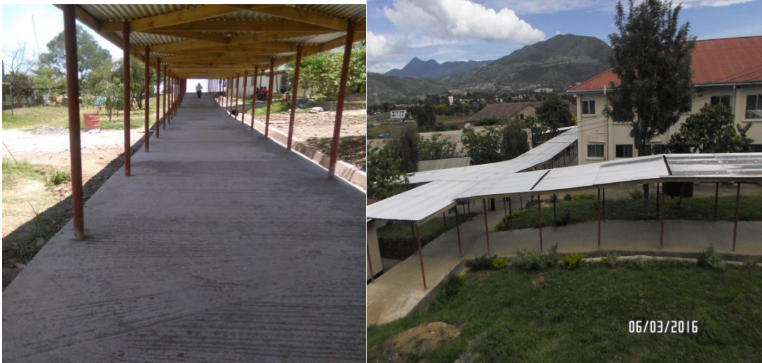
UJENZI WA NJIA ZA NDANI YA HOSPITALI
