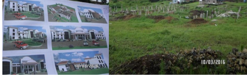
Ujenzi wa jengo la Halmashauri katika ngazi ya msingi.
