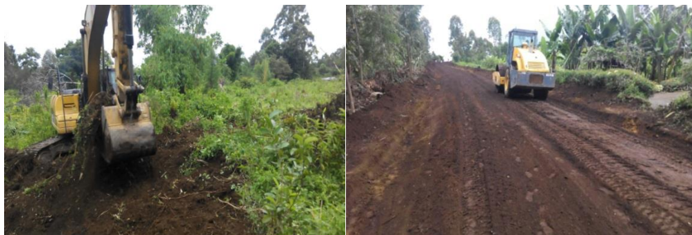
Ujenzi wa barabara Kutoka Mpanda hadi sokoni
