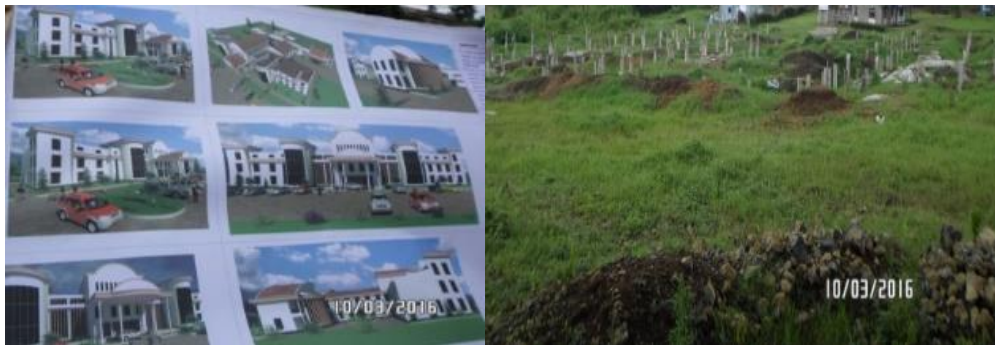
Mchoro wa jengo la ofisi ya Halmashauri na ujenzi ukiendelea.
