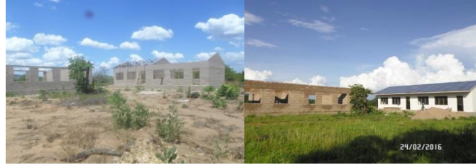
Ujenzi wa Sekondari ya Kata ya Chikoropola
