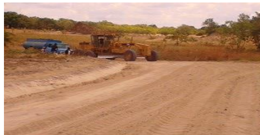
Ujenzi wa barabara ya Lekindo Madaba
