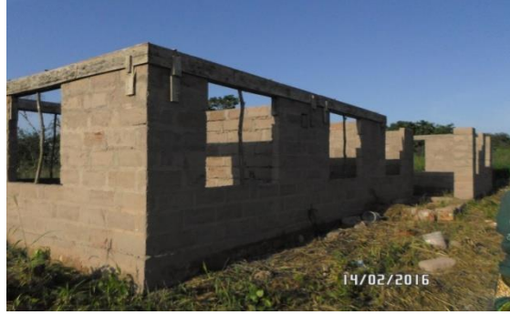
Ujenzi wa nyumba ya mwalimu shule ya msingi Likwaya
