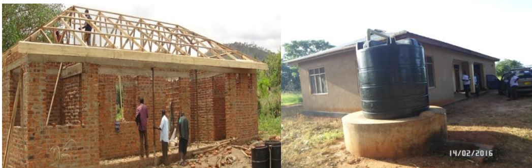
Ujenzi wa ofisi ya kijiji cha Kinyope ukiendelea na ofisi ya kijiji cha Likwaya ikiwa imekamilika
